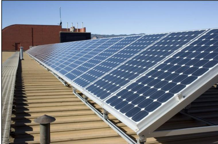
Imagen 15. Ejemplo de placas solares instaladas en cubierta
